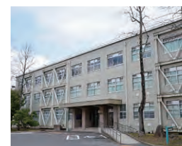
■総合理工学部2号館
